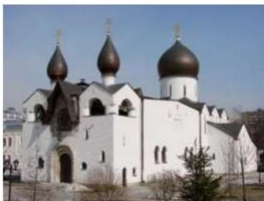
Вид с северо-запада
